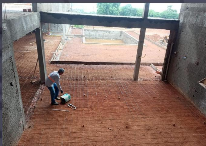
INSTALAÇÃO DE MALHA DE FERRO PARA CONTRAPISO
